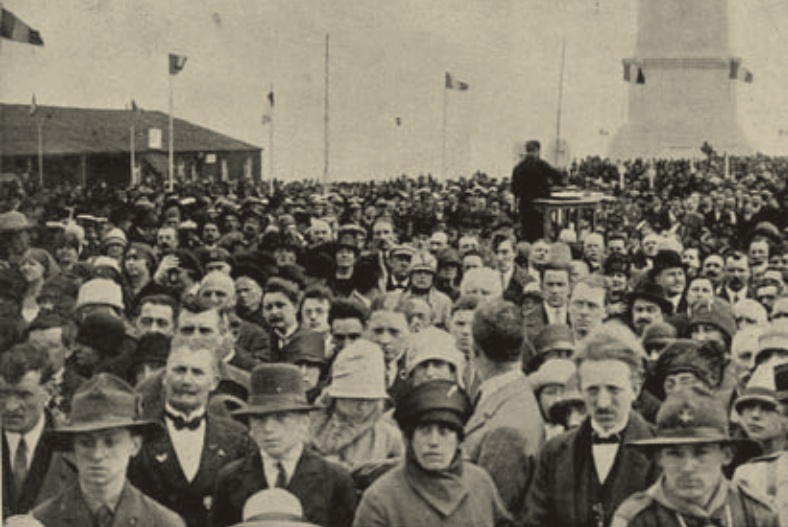
La foule lors de l'inauguration de la tour-lanterne le 2 août 1925.
