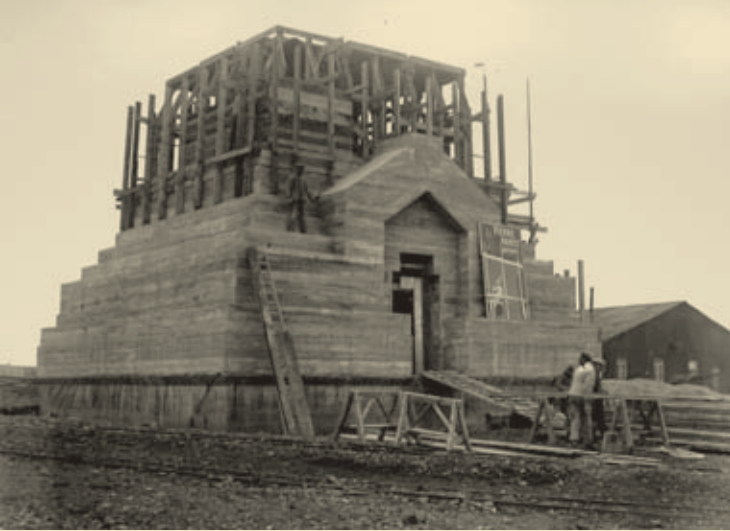
La tour-lanterne en construction.
