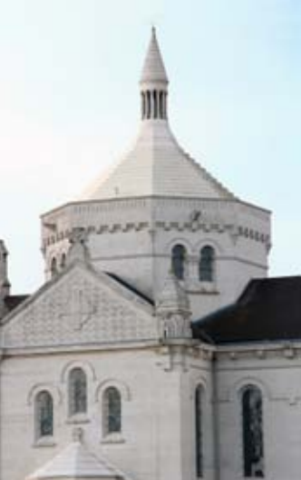
La coupole de la chapelle.
