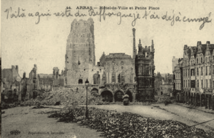
Les ruines de l'hôtel de ville et du beffroi d'Arras à la fin de l'année 1915.
