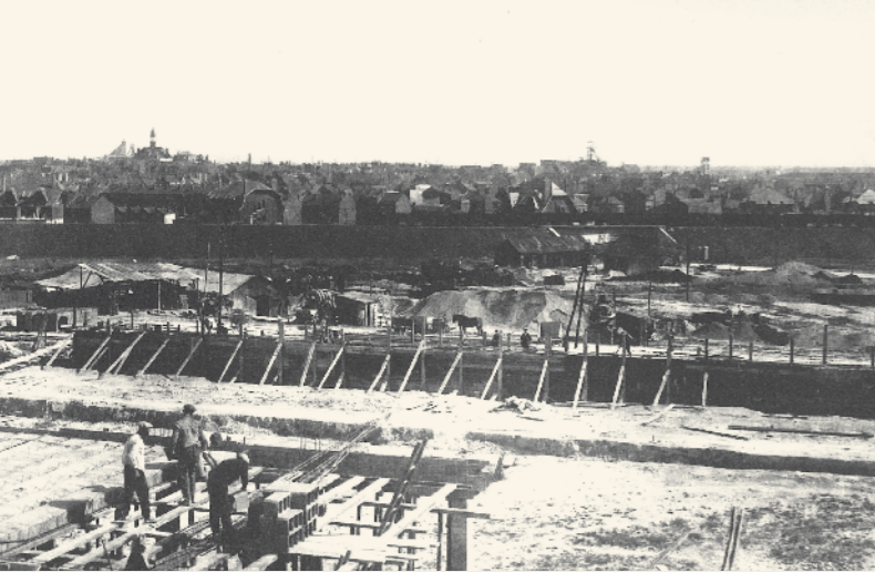
Les fondations de la façade principale en août 1928.
