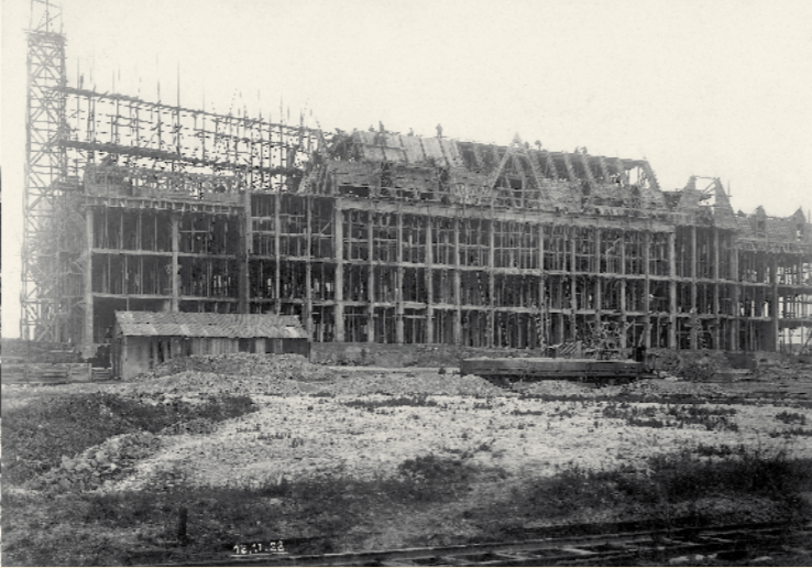
La façade principale en novembre 1928. Cordonnier a eu recours au béton armé pour l'ossature et la charpente du bâtiment.
