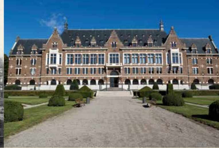
La façade monumentale des grands bureaux.
