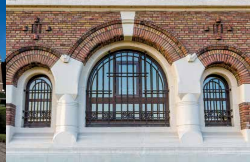
Décors géométriques jouant sur l'alternance des matériaux, la bichromie et le jeu de retraits et saillies à partir de l'appareillage en brique.
