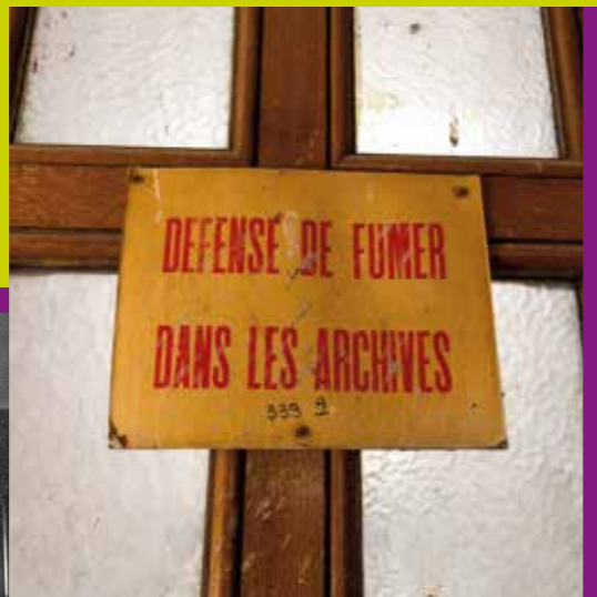
Porte d'entrée des archives situées au dernier étage du bâtiment.
