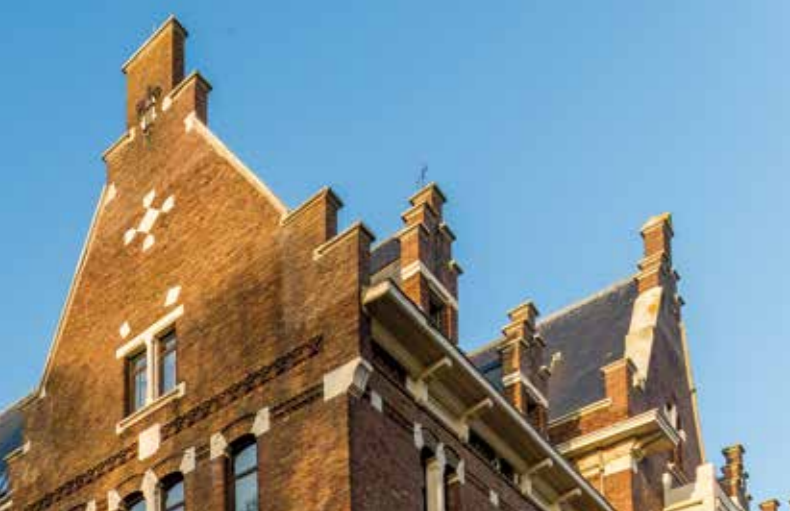
Détail sur les pignons à redents.
