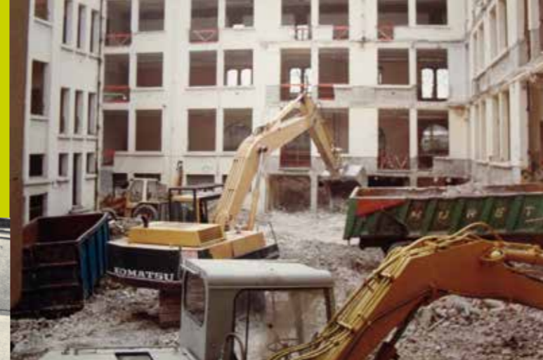
La cour nord pendant les travaux.
