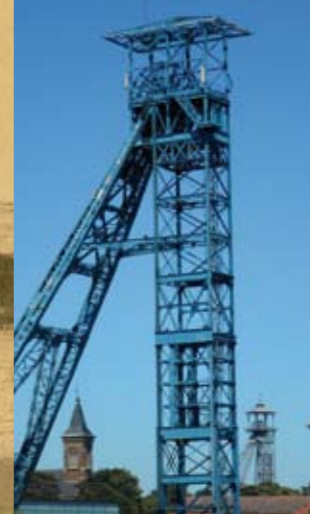
Le chevalement I bis de Liévin et, au second plan, le chevalement 3 bis de Lens.
