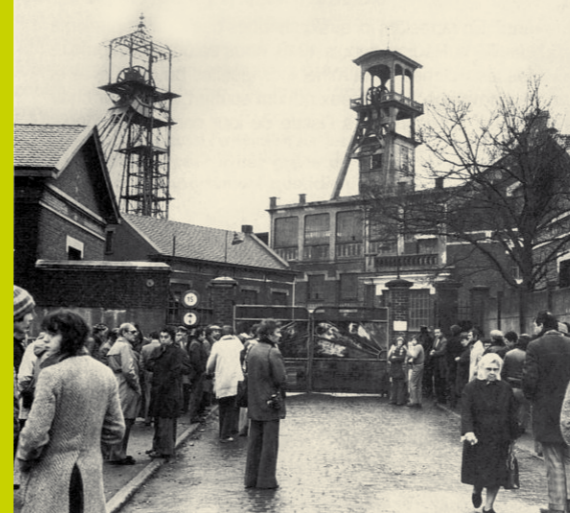
Les familles se pressent à l'entrée du carreau de fosse pour avoir des nouvelles de leurs proches.
