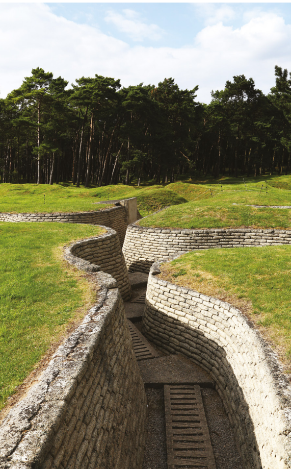
Tranchées, site de Vimy © M. Brard / CALL
