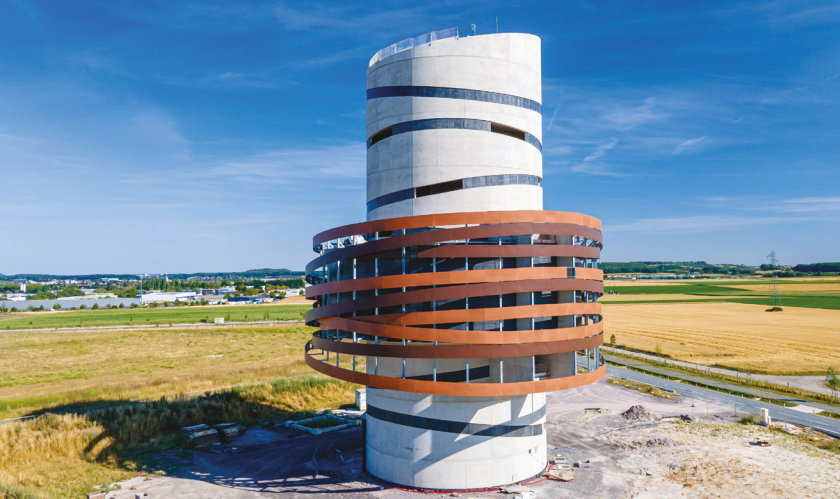
Château d'eau, Bully-les-Mines
